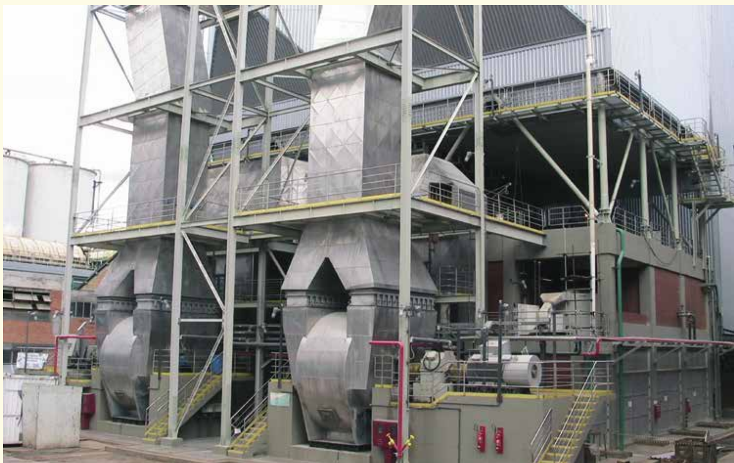
2xD34 KSL, 2000 kW - 1200 giri/min. Ventilatore (Brasile)
