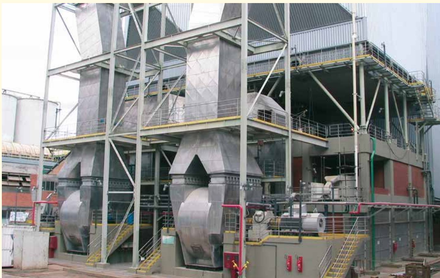
2xD34 KSL, 2000 kW - 1200 trs/min, ventilateur (Brésil)
