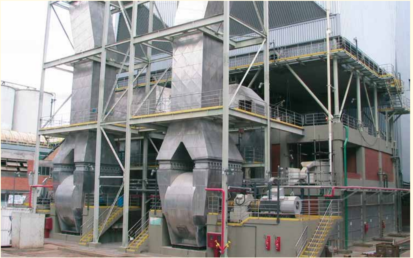
2xD34 KSL, 2000 kW - 1200 giri/min. Ventilatore (Brasile)
